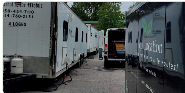
Remorque Power Pack 100K sur un camp de base de production, Montréal.
